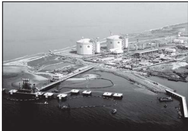
Construction of upcoming LNG Terminal at Kochi
