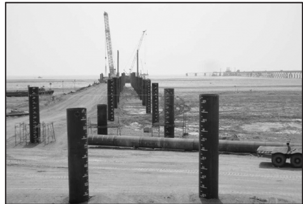
Construction of Second LNG Jetty at Dahej
