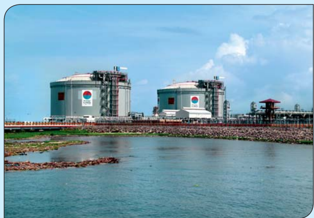
Kochi LNG Terminal
