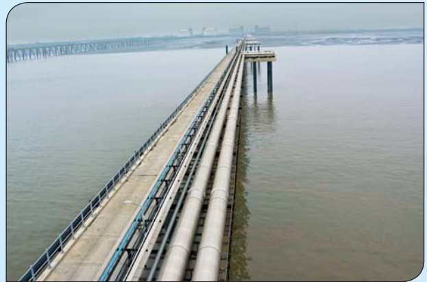
Second LNG Jetty at Dahej
