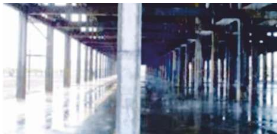
Ambient Air Heater at Dahej LNG Terminal
