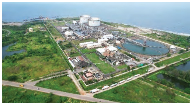
Kochi LNG Terminal
