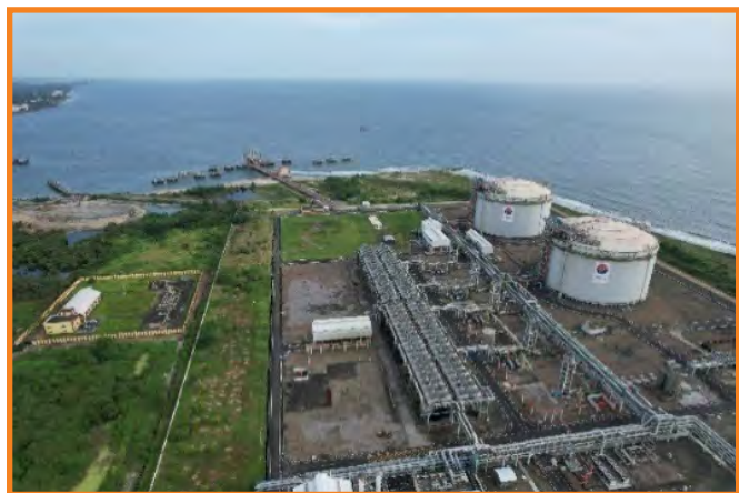
Kochi LNG Terminal
