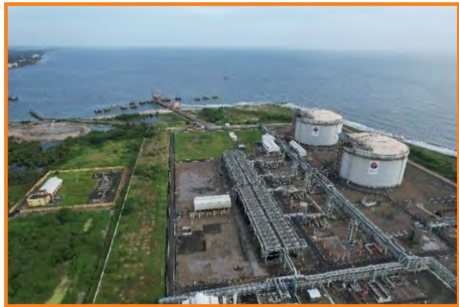
Kochi LNG Terminal
