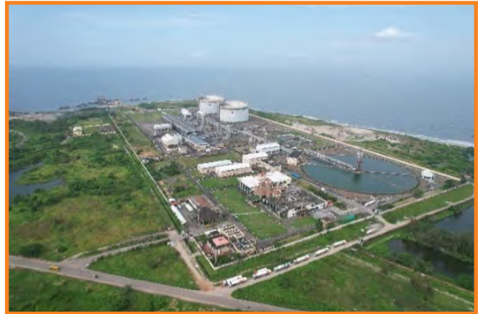
Kochi LNG Terminal
